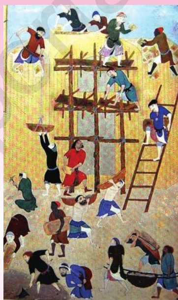
К. Бехзод. Строительство мечети
